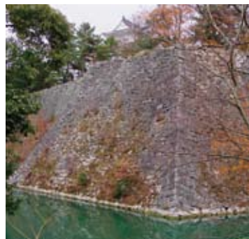
▲藤堂高虎が築いた高石垣。根石から天端までは約30メートル
